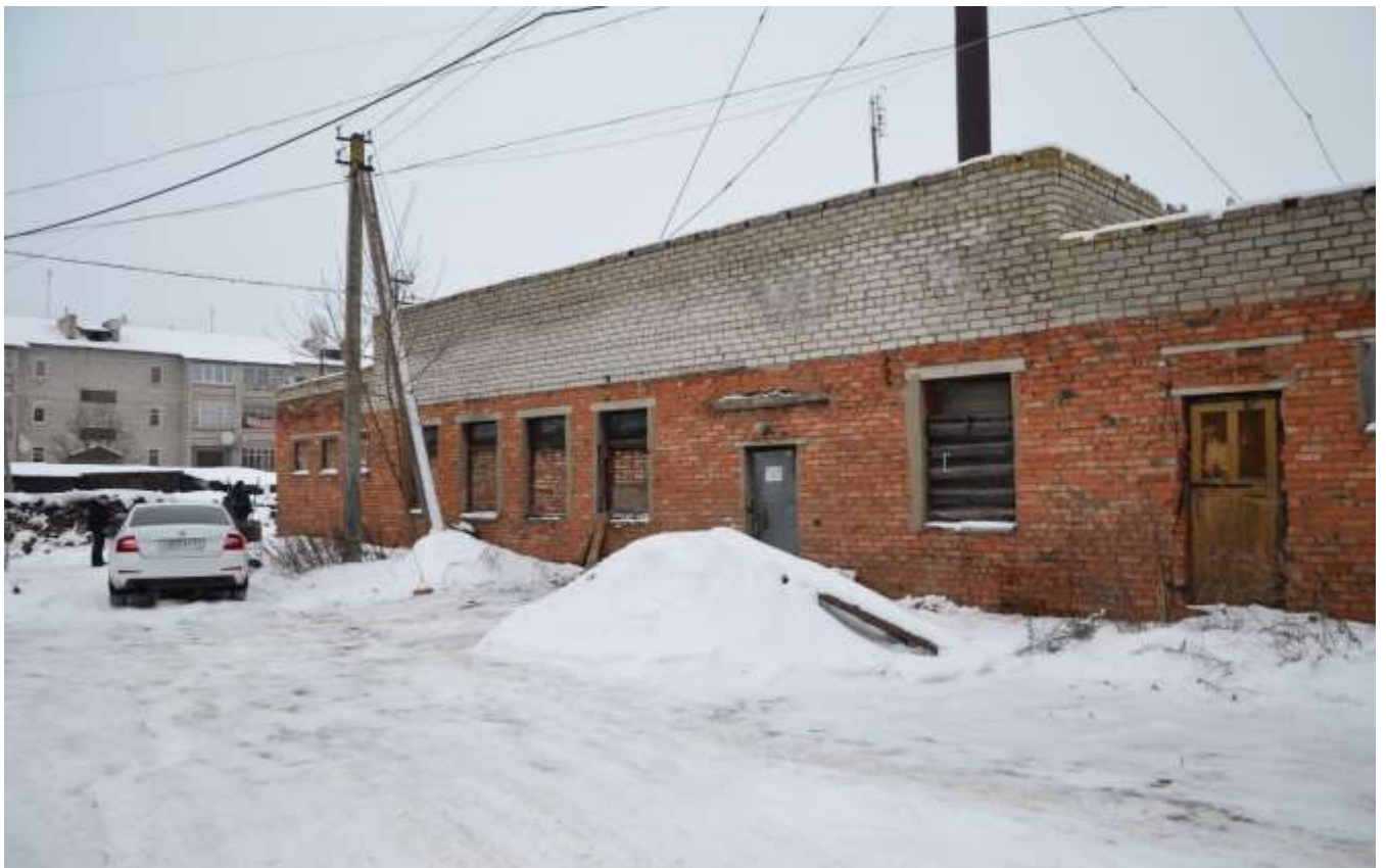
Рис. 3.28 Здание котельной РУС
