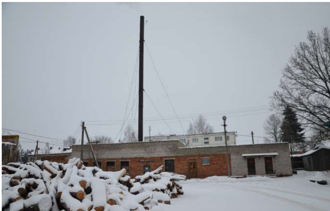
Рис. 3.27 Здание котельной РУС
