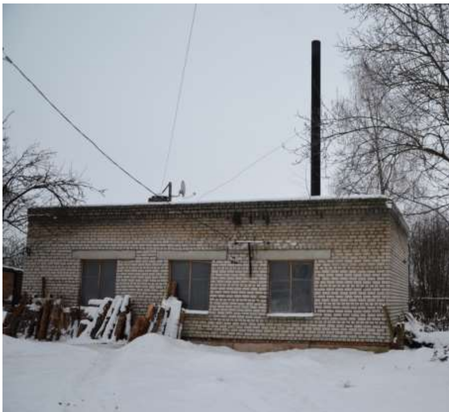
Рис. 3.9. Здание котельной д/с №5
