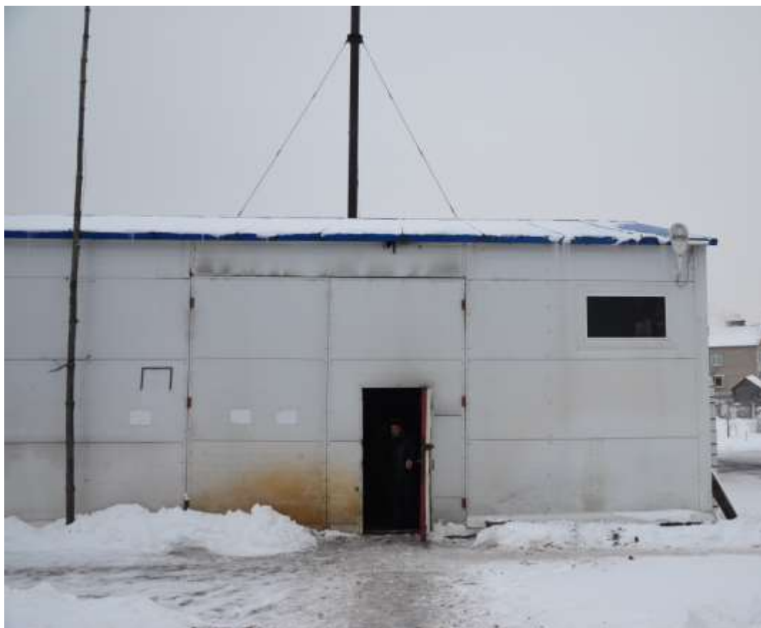
Рис. 3.22. Здание котельной Судоверфи.
