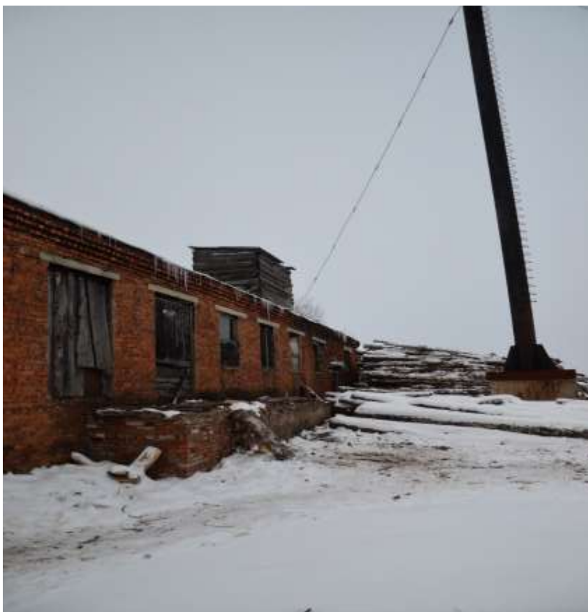
Рис. 3.40 Здание котельной ПМК 1313
