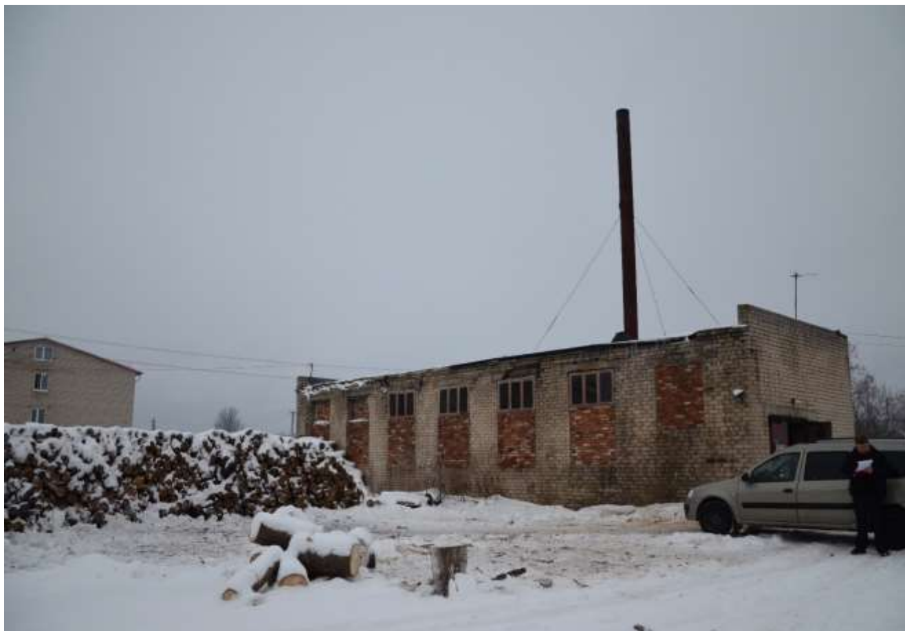
Рис. 3.46 Здание котельной 8 Марта
