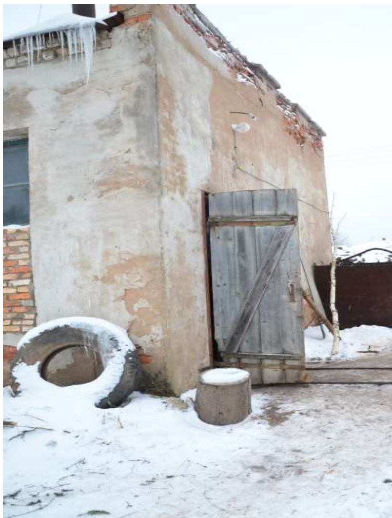
Рис. 3.15. Здание котельной ЛПХ.
