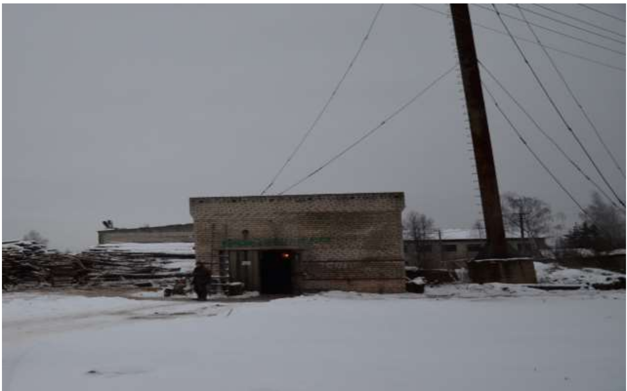
Рис. 3.51 Здание котельной ДСПМК
