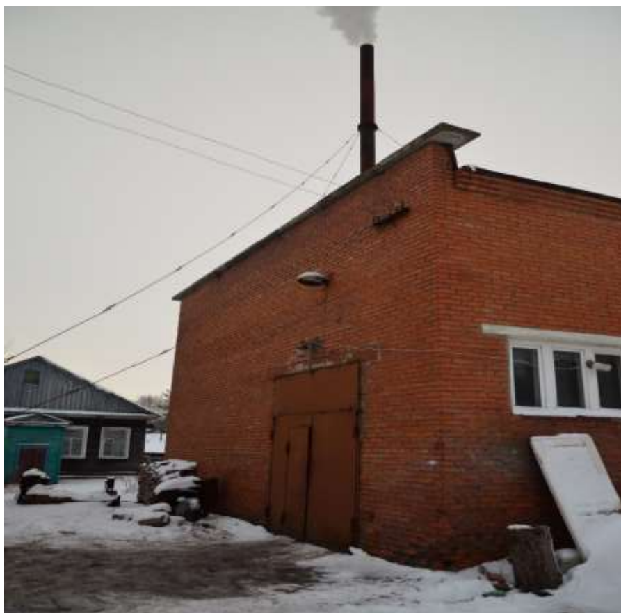
Рис. 3.33 Здание котельной Центральная
