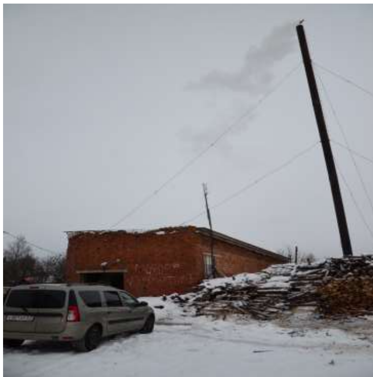
Рис. 3.56 Здание котельной 8 Марта
