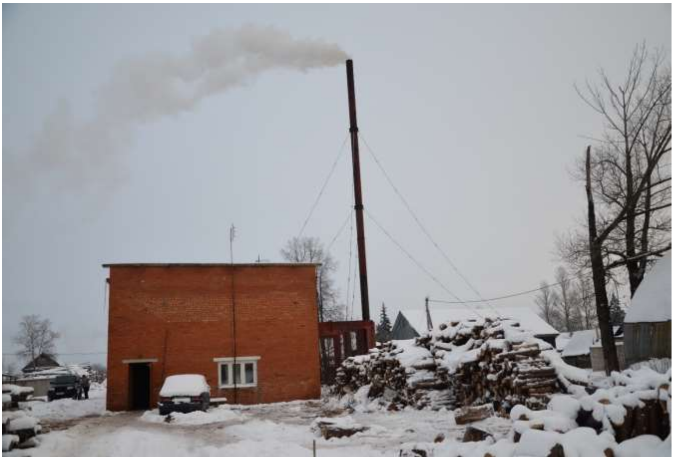
Рис. 3.34 Здание котельной Центральная
