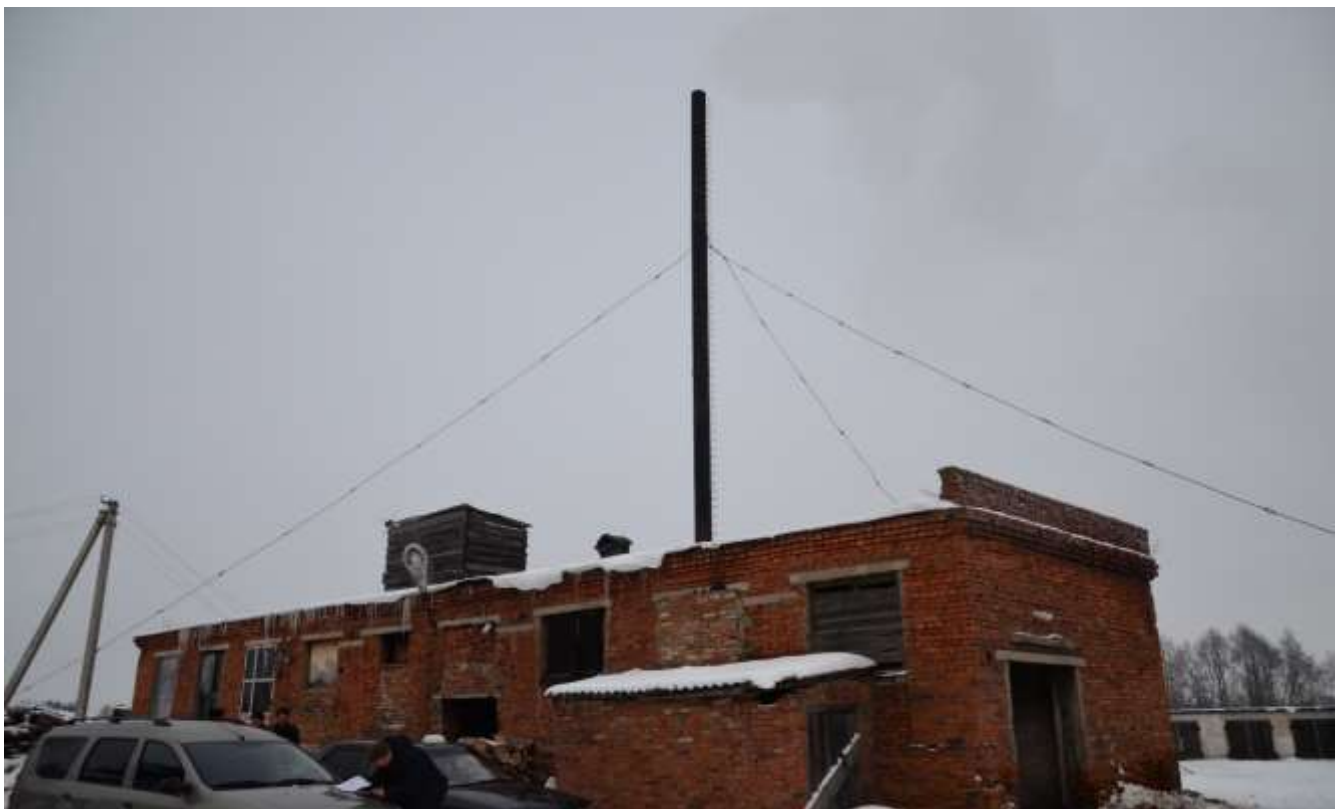
Рис. 3.39 Здание котельной ПМК 1313
