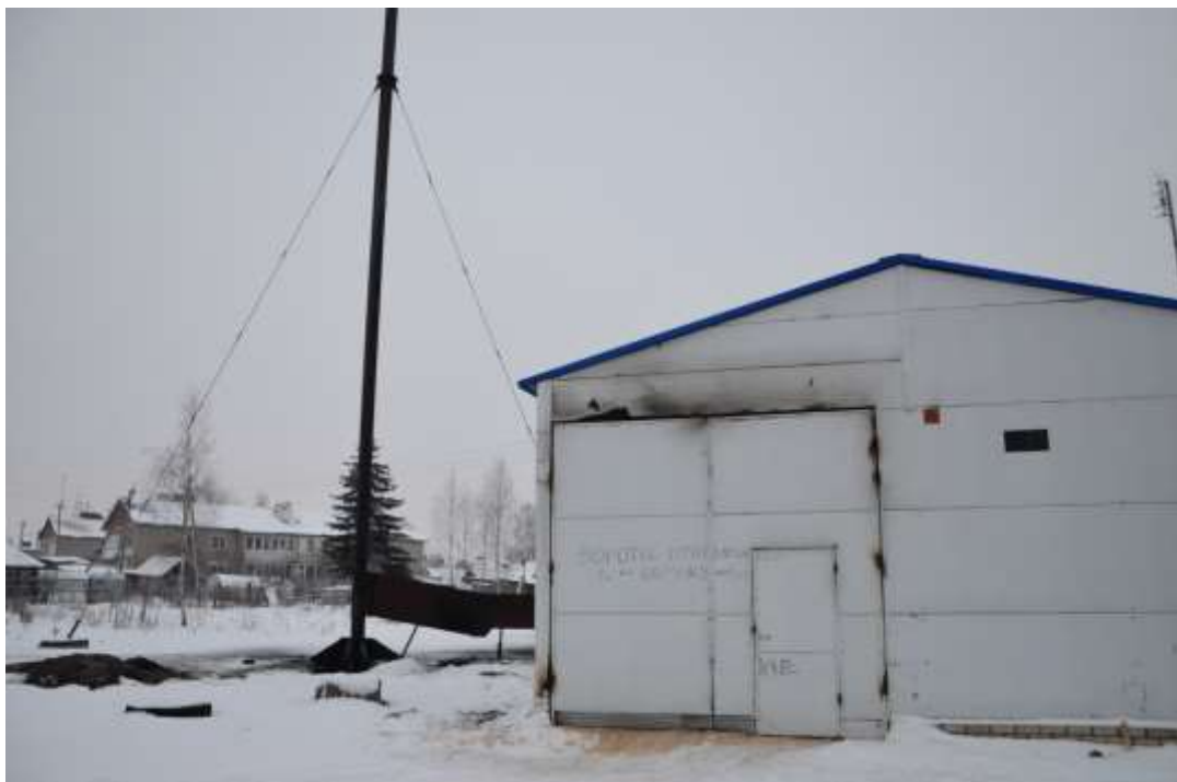
Рис. 3.21. Здание котельной Судоверфи.
