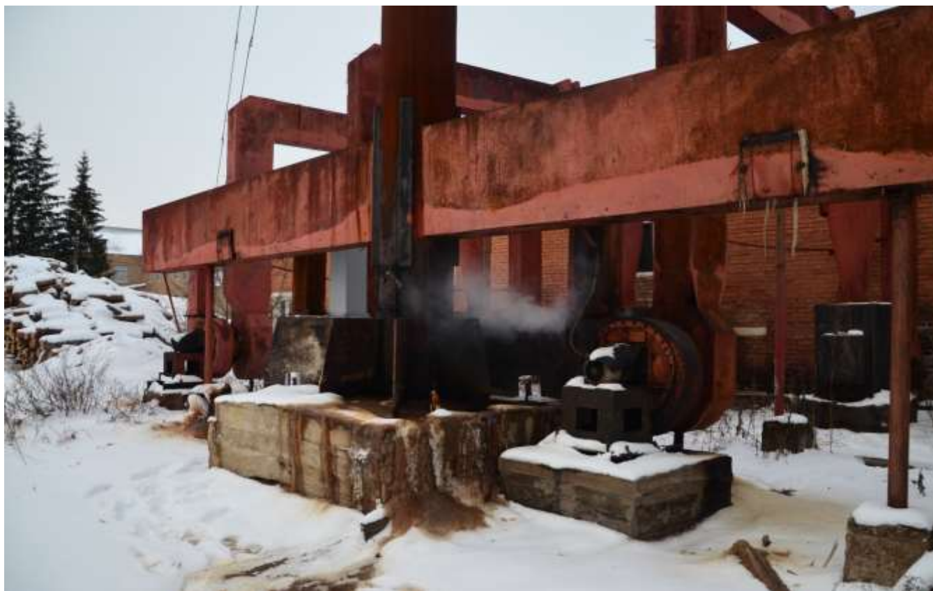
Рис. 3.38 Состояние дымососов
