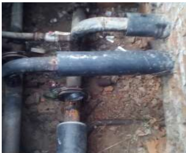
Рис. 3.60 Тепловые сети и тепловые камеры котельной ЦРБ
