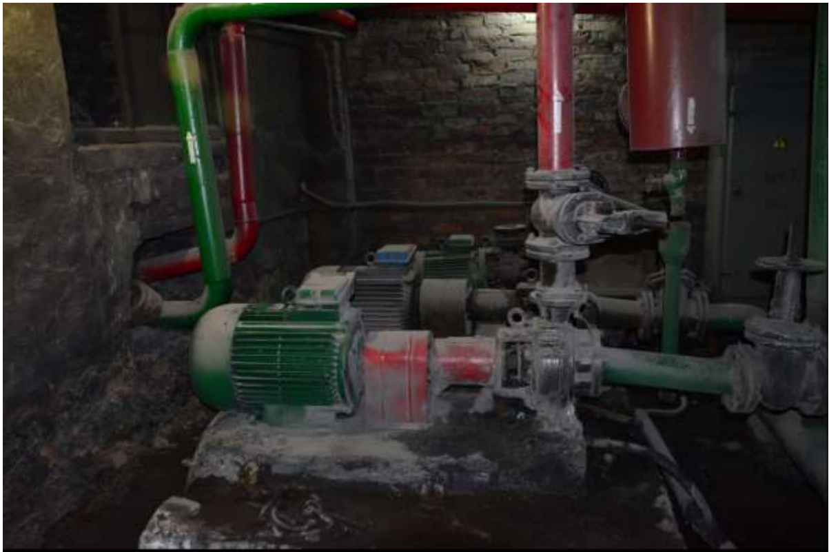
Рис. 3.7. Состояние насосной группы котельной ЦРБ
