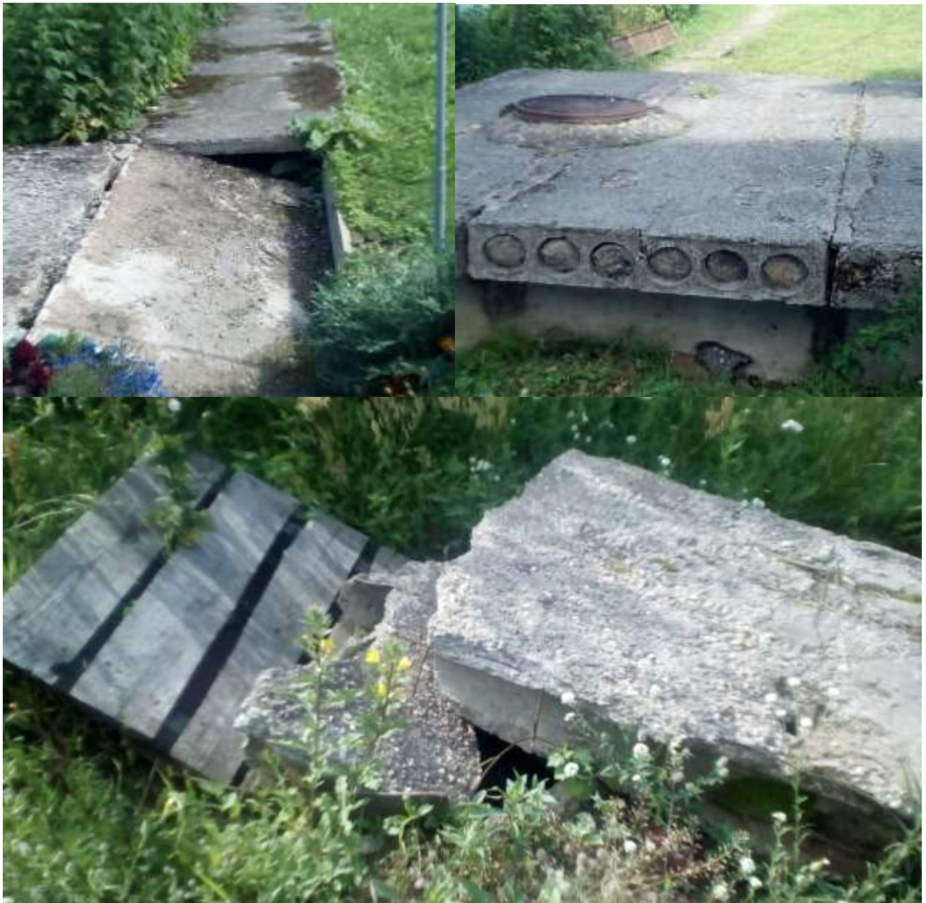
Рис. 3.65 Тепловые сети и тепловые камеры котельной ДСПМК
