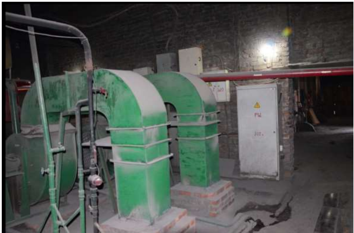
Рис. 3.8. Вентиляторы поддува котельной ЦРБ
