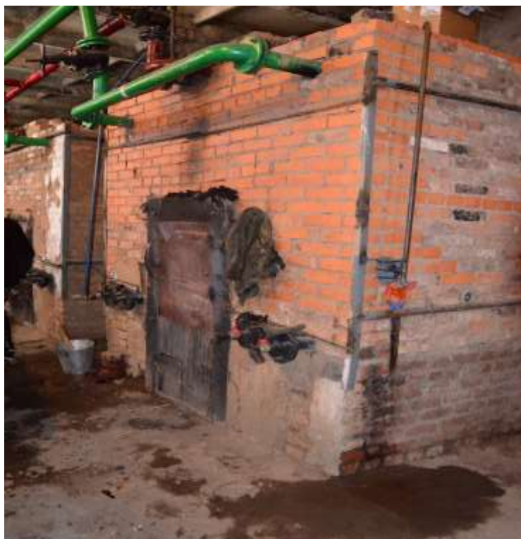
Рис. 3.58 Состояние котлов
